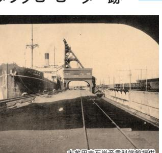
正式名称は「特許三池式快速船積機」。それまで人力に頼っていた石炭積み込み作業を飛躍的に効率化させました。
