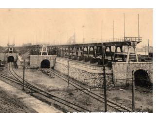
宮原坑や万田坑などの各坑口から採掘された石炭は、専用鉄道により運ばれ、この貯炭場におろされました。石炭運搬船には、「ダンクロ・ローダー」を使って積み込みが行われ、三池炭は海路を通じて国内外へと運ばれました。
