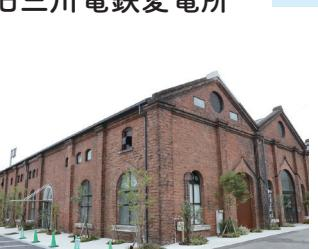
1909（明治42）年以前に造られたとされ、三池炭鉱専用鉄道の変電所に使用された建物です。四山発電所で起きた電力を、鉄道用に変換する施設として建てられたものです。建物は煉瓦造りの切妻平屋が2棟連続した姿をしています。現在も会社の事務所として使われています。
