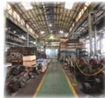
修繕工場内部(現状)
