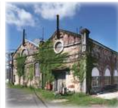
遠賀川水源地ポンプ室外観(現状)
