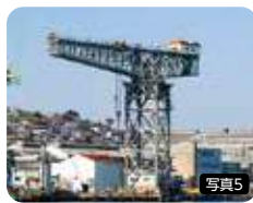
6-3 三菱長崎造船所ジャイアントカンチレバークレーン
