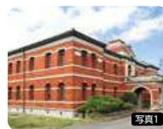
8-1 官営八幡製鐵所 (非公開施設)
